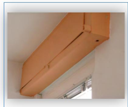
Abb. 139: 1950 ff. Undicht und mit großer Wärmeverlustfläche,  $U = 3,0 \text{ W}/(\text{m}^2\text{K})$
