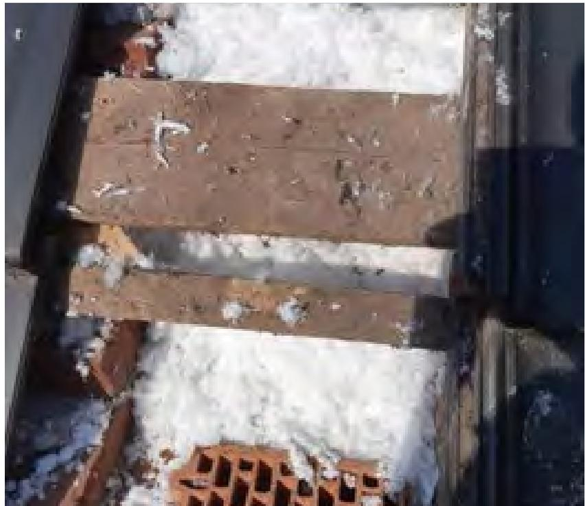
Abb. 96: Abseitendämmung von außen durch aufgenommene Dachziegel
