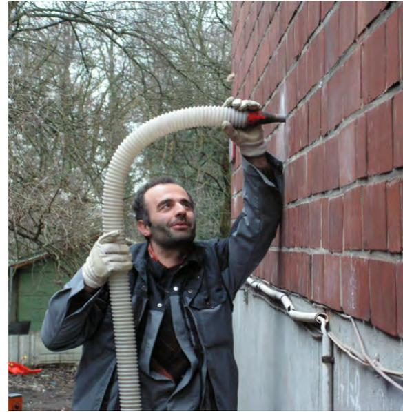
Polyurethan-Gießschaum kommt zum Einsatz, wenn die Hohl-schichtdämmung auch die Mauerwerk-Außenschale durch Verklebung sichern soll. Tabelle 7 gibt einen Überblick über die Materialien.
