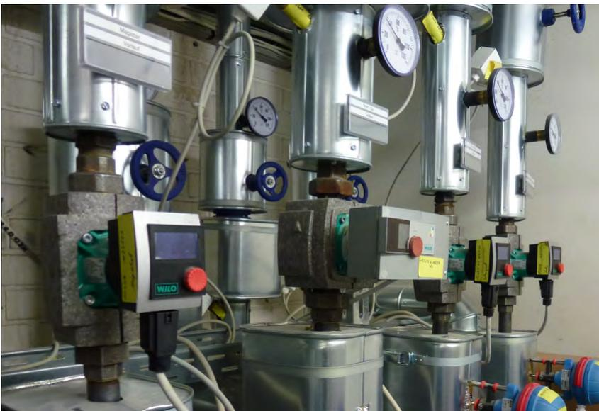
Bild 1: Hocheffizienzpumpen nach Modernisierung der Kesselanlage zum BHKW im Rathaus Mörfelden 2014 (Südhessen)
