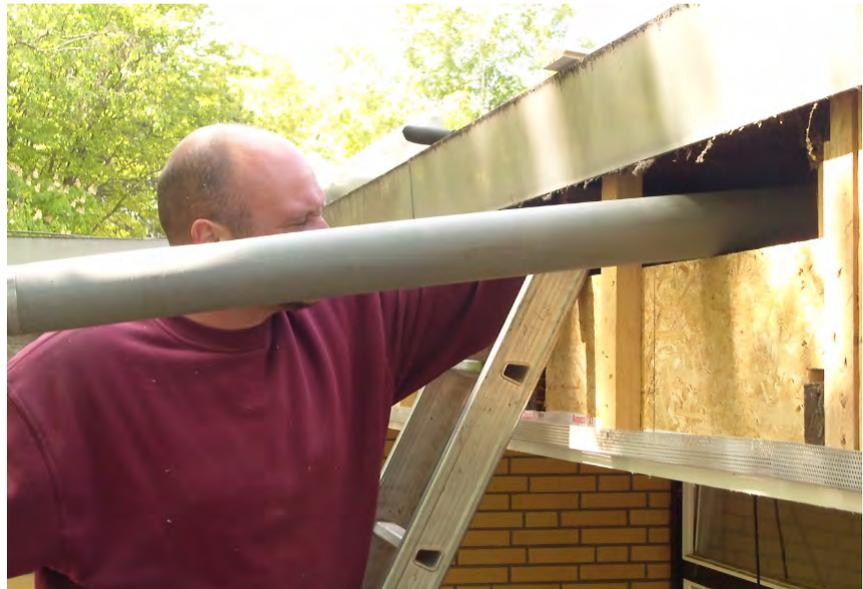
Abb. 117: Einblasen von Dämmflocken vom Dachrand
