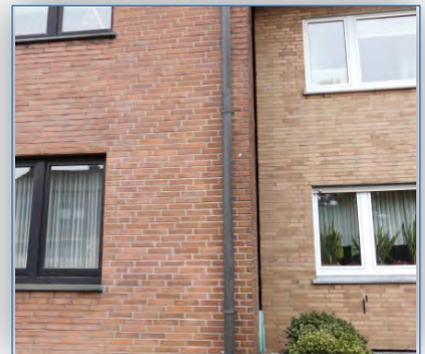
Abb. 149: Gedämmte Trennwandfuge
