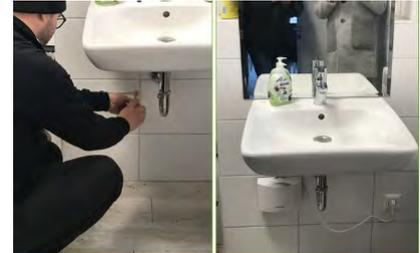
Abb. 12: Vergleichsmessung Stromverbrauch 5-Liter-Kleinspeicher und 3,5 kW Klein-DLE bei gleichem Verbrauchsprofil im Projekt „Klimagaarden“ in Kiel
