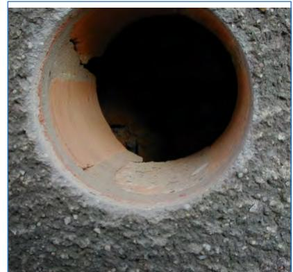
Abb 43: Blick in den funktionslosen Luftzwischenraum
