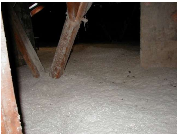
Abbildung 40: Aufsteigende Hölzer: fugenfrei
