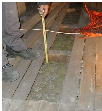
Abbildung 14: 4 cm vorhandene Dämmung, 10 cm Hohlraum
