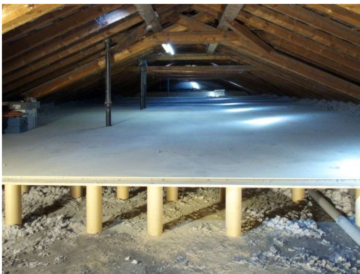
Abbildung 20: Obere Geschossdecke, begehbar (Projekt „OGD 55 Schulen Köln Passivhaus-Standard“)
