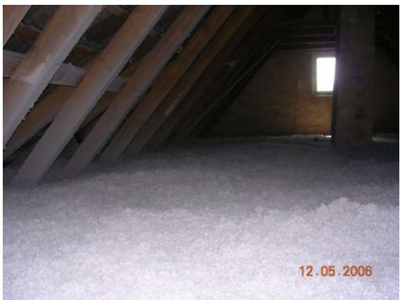
Abbildung 39: Homogene Dämmschicht ohne Lücken
