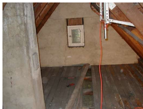
Abbildung 16: 2 cm vorhandene Dämmung, 12 cm Hohlraum
