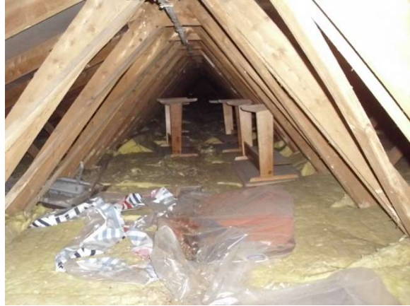
Abbildung 33: Nicht druckbelastbare Dämmung als Abstellraum
