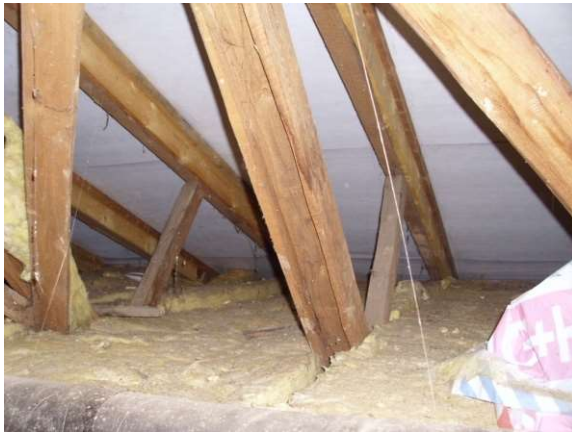
Abbildung 35: Aufsteigende Balken mit Mattendämmung
