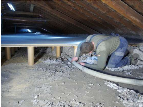
Abbildung 21: Verfüllung des Hohlraumes mit Abstandhaltern
